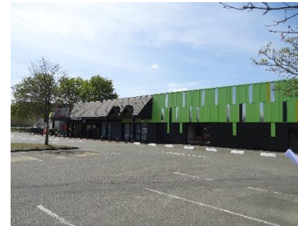
SPAR et Gymnase – Moncé-en-Belin
