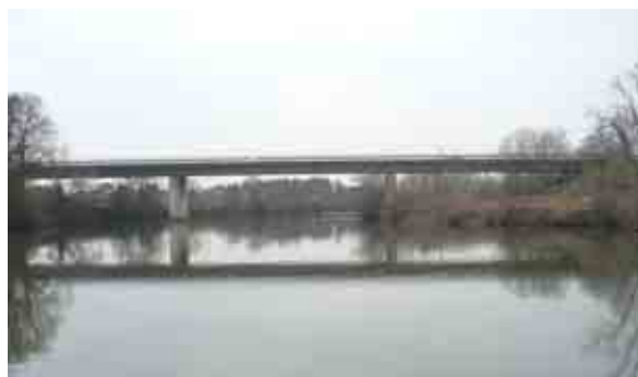
Figure 12: N23 coupant la Sarthe à hauteur de Spay
