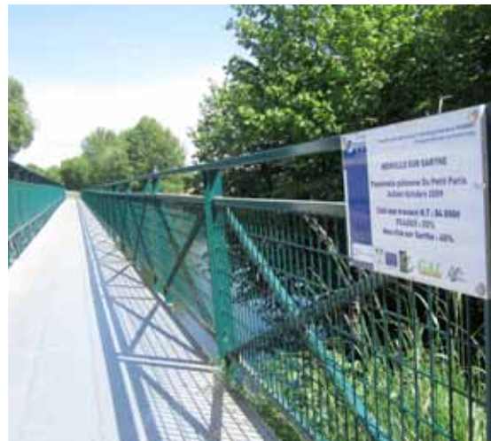
Passerelle piétonne du Petit Paris à Neuville-sur-Sarthe
